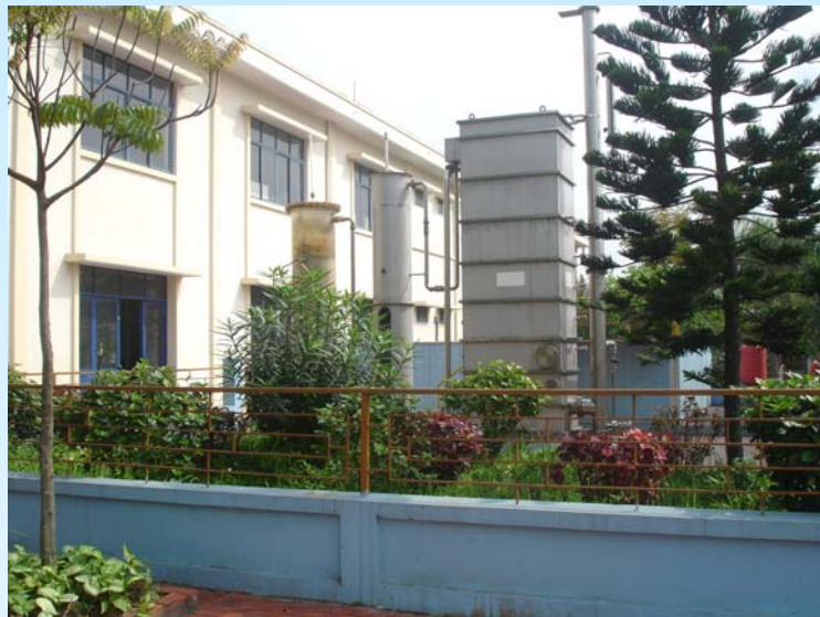
Station de traitement de l'eau surface 140m 3 /jour
